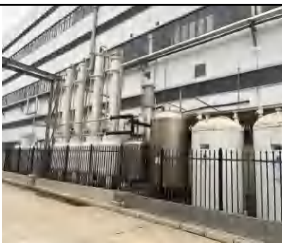
生产车间罐区围堰
