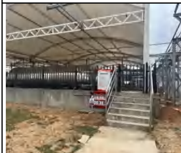
储罐区围堰
