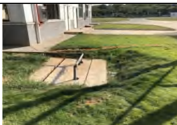
厂房废水收集池
